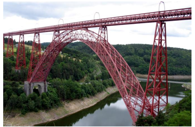
Viaduc de Garabit
