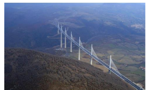
Viaduc de Millau
